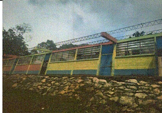
Instalacion de puertas y ventanas de la escuela primaria
