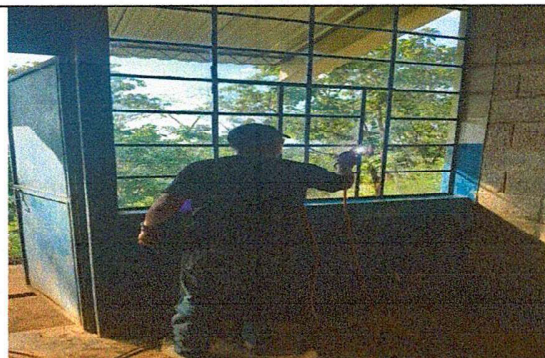
Colocacion de Ventanas con vidrios de la escuela.
