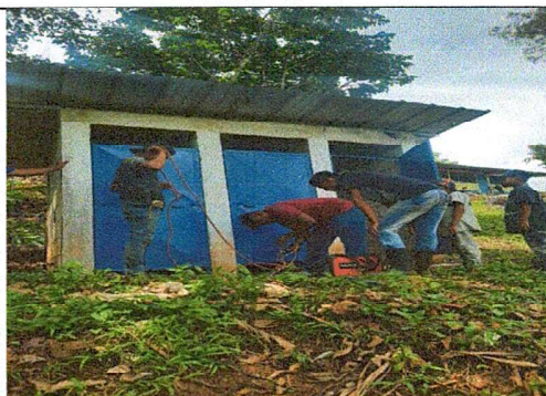
Instalacion de puertas de letrinas de la escuela.
