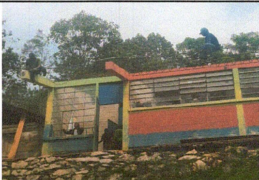
inicio del trabajo del entechado de la escuela de primaria
